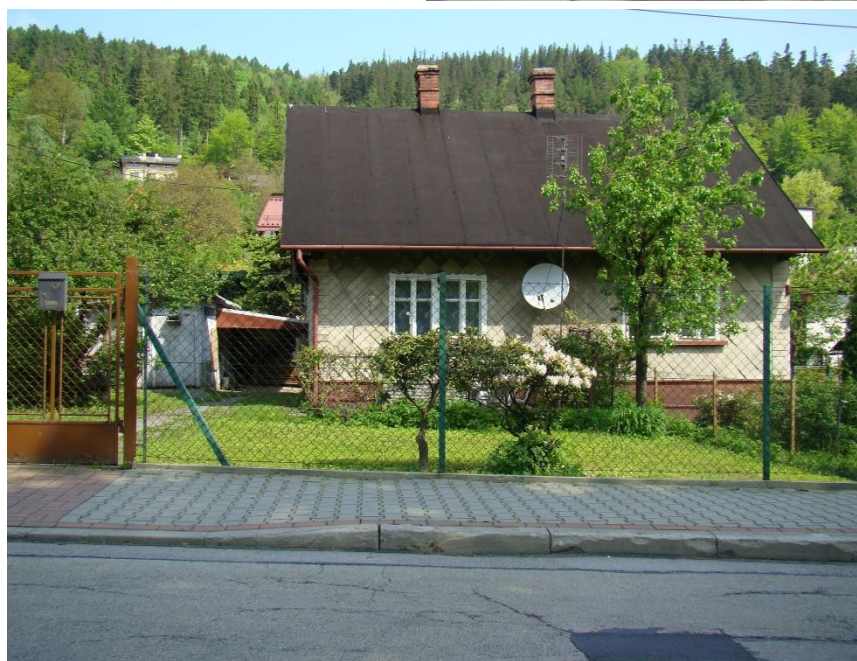
Widok budynku od strony pd
