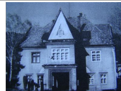
Fot. archiwalna, widok obiektu od strony pd
