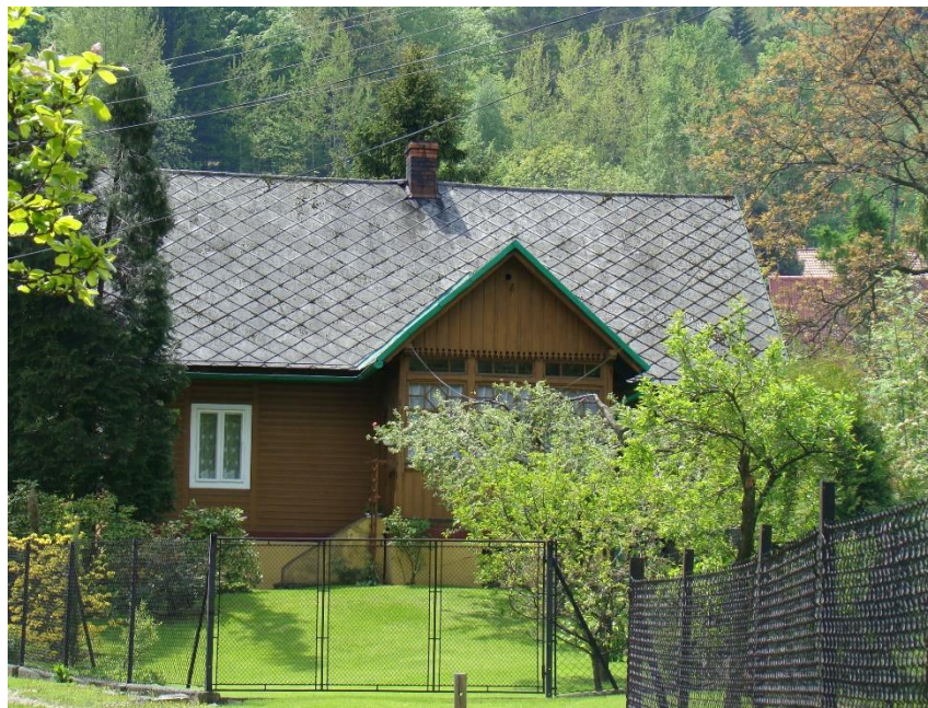
Widok budynku od strony pn
