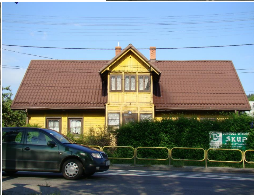
Widok budynku od strony wsch 2010r.
