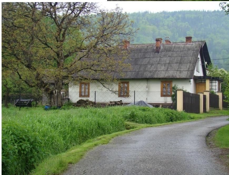
Widok budynku od strony wsch
