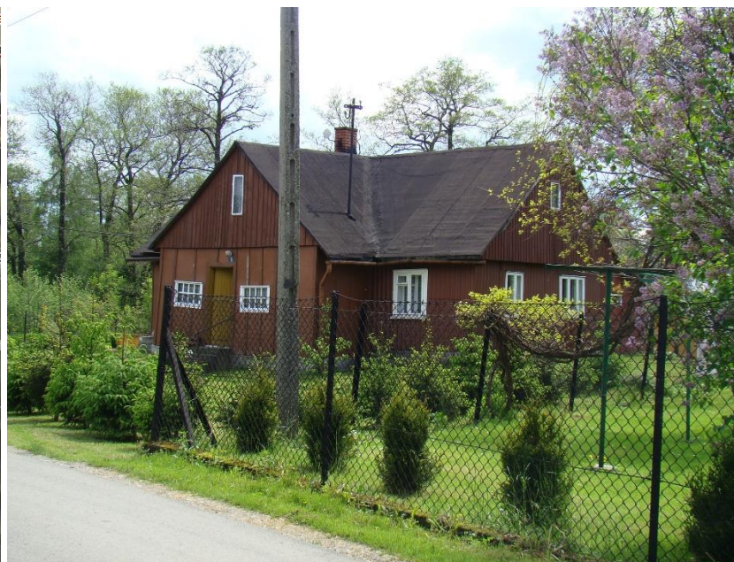
Widok budynku od strony pn-wsch
