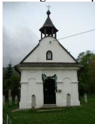
Widok frontowy kaplicy
