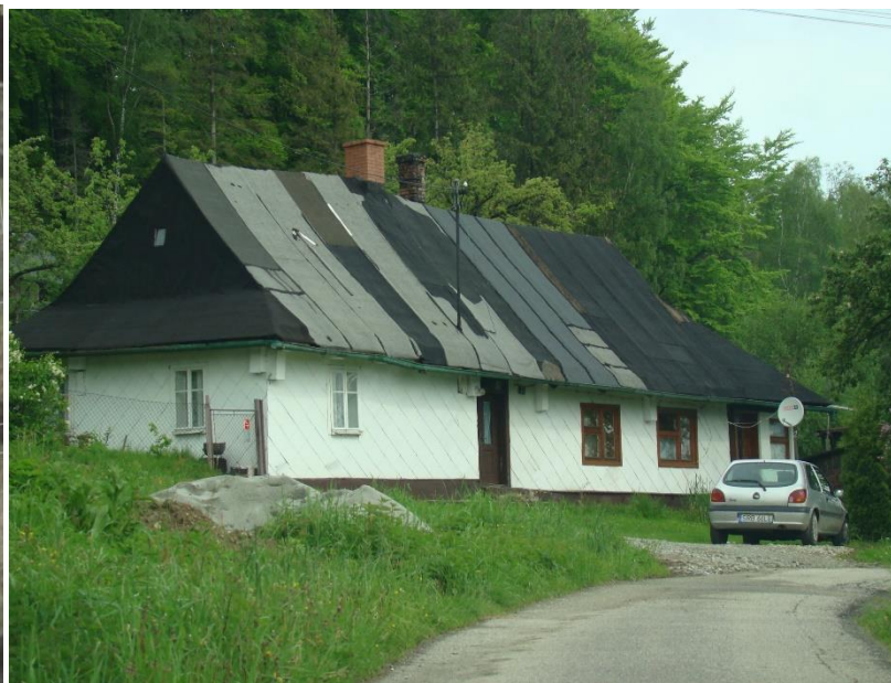
Widok budynku od strony pd
