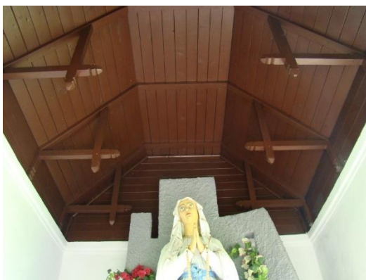
Widok kaplicy od strony pd-wsch
