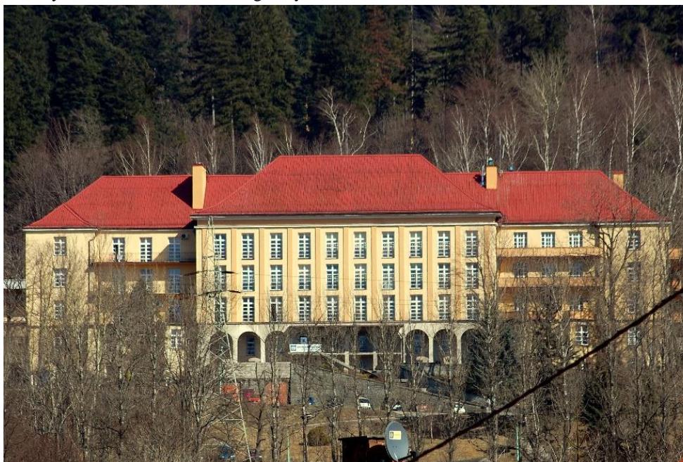
Widok frontowy budynku szpitala (od strony pd-zach)
