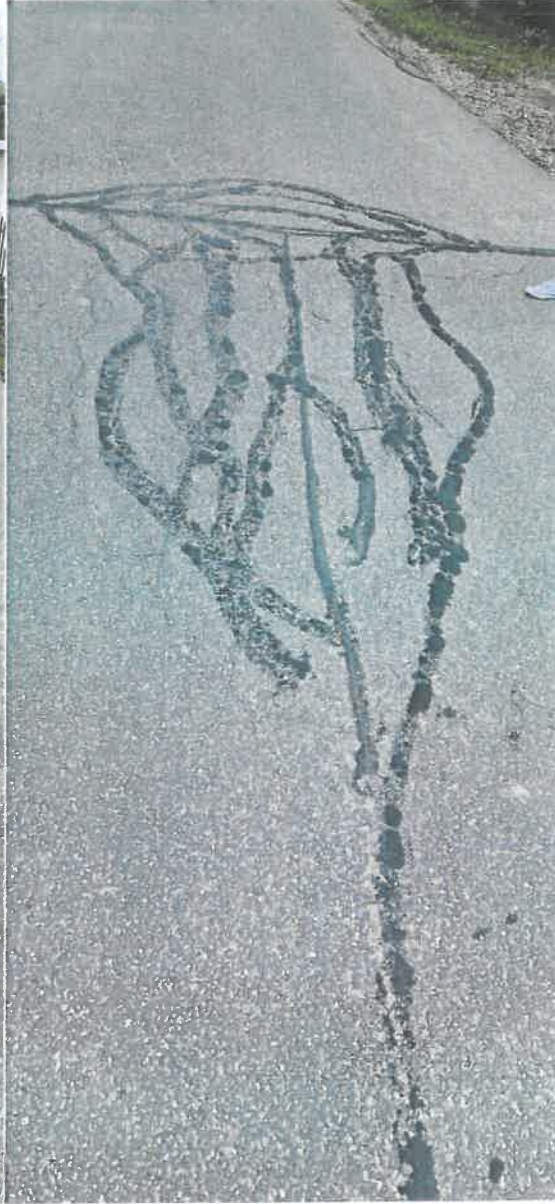
6. Ul. Kościelna połączenie etapów robót (Sportowa, Kościelna Brzozowa)
